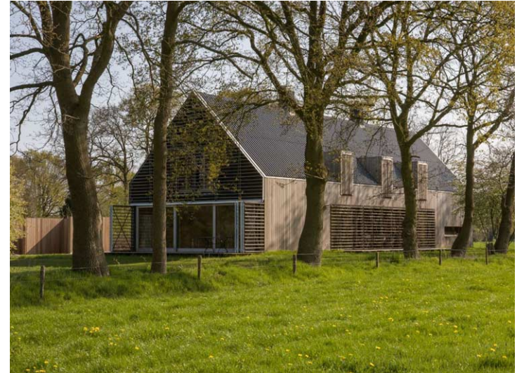
houten gevel, golfplaten dak, luiken, dakkapellen
