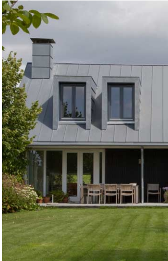
dak en dakkapel zink
